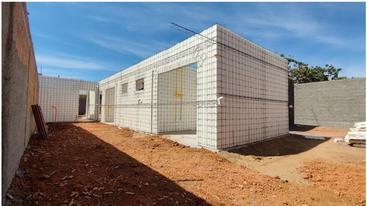
Figura 3: Casa em construção com painéis monolíticos.
